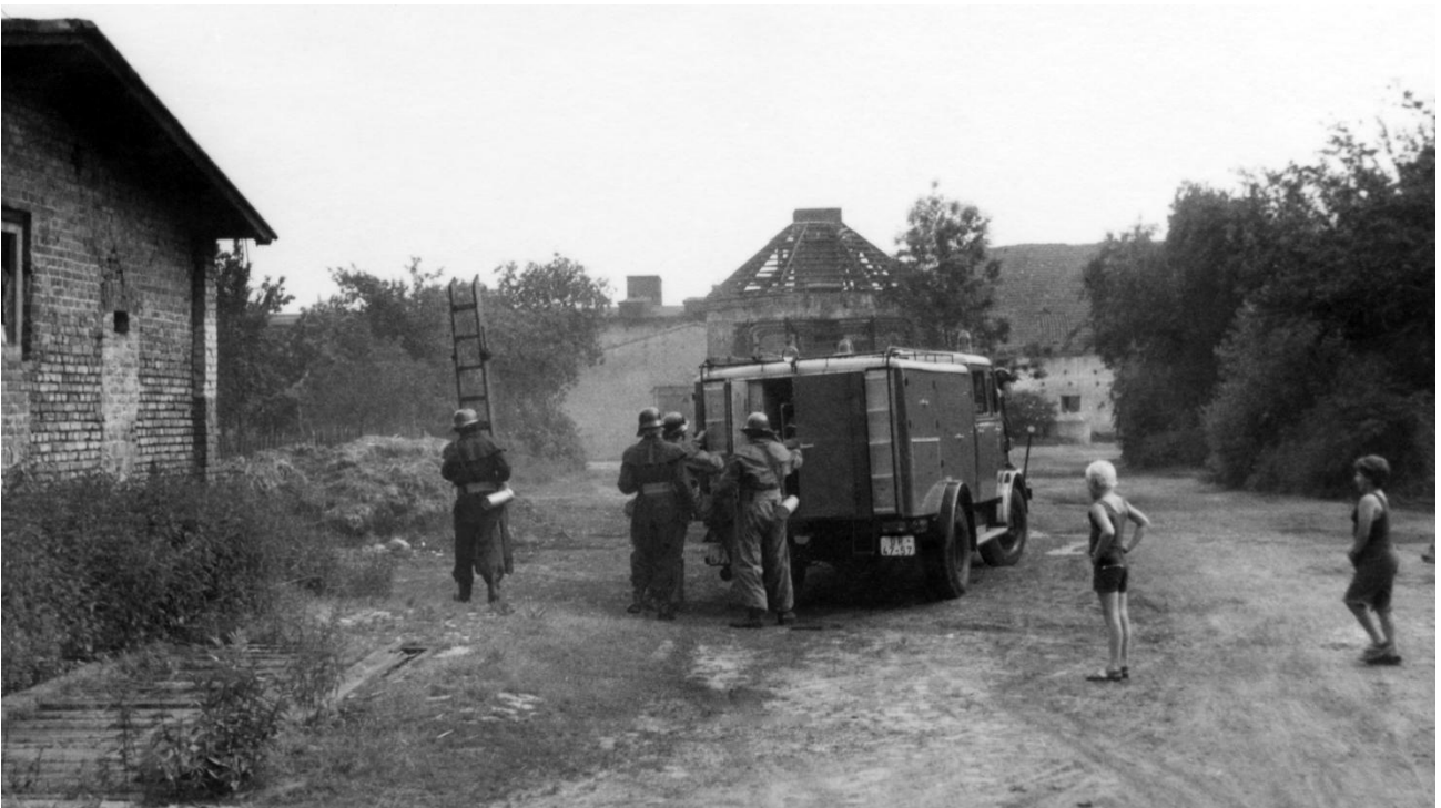
Mitte der 1970er Jahre der ehemalige Gutshof mit der eigentlich schon fast hoffnungslosen Ruine des Backhauses als Austragungsort einer Feuerwehrrübung. Fotograf unbekannt
