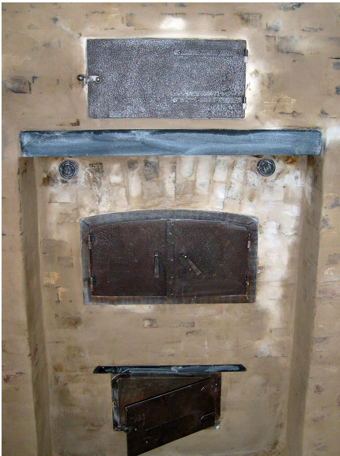
Die fertiggestellte neue Ofenfront mit neu angepassten Ofentüren aus scheinbar historischen Türelementen. Bild Petra Gentes Ofenbaumeister Andreas Fleischer aus Potsdam errichtete den neuen Holzbackofen und Schornsteinfegermeister Thomas Balzus & Sohn aus Waltersdorf übernahmen dessen Bauaufsicht.
