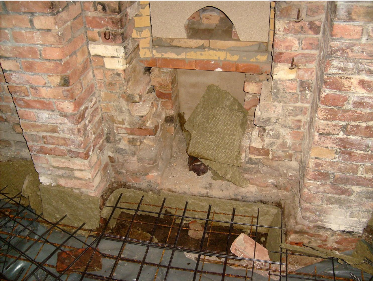
Oben rechts im Bild befinden sich die Türkloben der alten Ofentür und deren Türriegel links. Die ursprüngliche Ofentür hatte einen Rechtsanschlag und ging über die gesamte Ofenöffnung. Was den Nachteil mit sich brachte, dass die heiße Ofentür beim Öffnen weit in den Raum hinein ragte. Bild Petra Gentes
