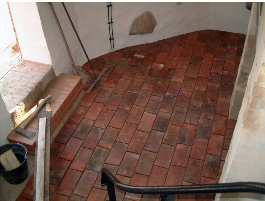
Im Bodenbereich wurde das Mauerwerk neu isoliert und ein neuer Fußboden aus Beton eingebracht. Auf den Beton wurden dann neue Fußbodenklinker aufgebracht.
