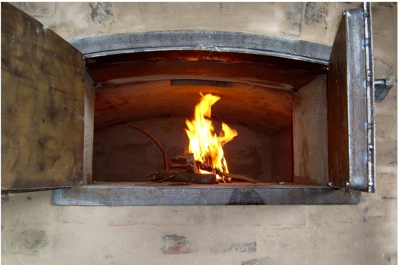
Ein Test für den Abzug der Brandgase. Gut erkennbar die neu geschweißten und gut isolierten Ofentüren welche nun durch einen Rahmen aus Stahl gehalten werden. Bild Petra Gentes
