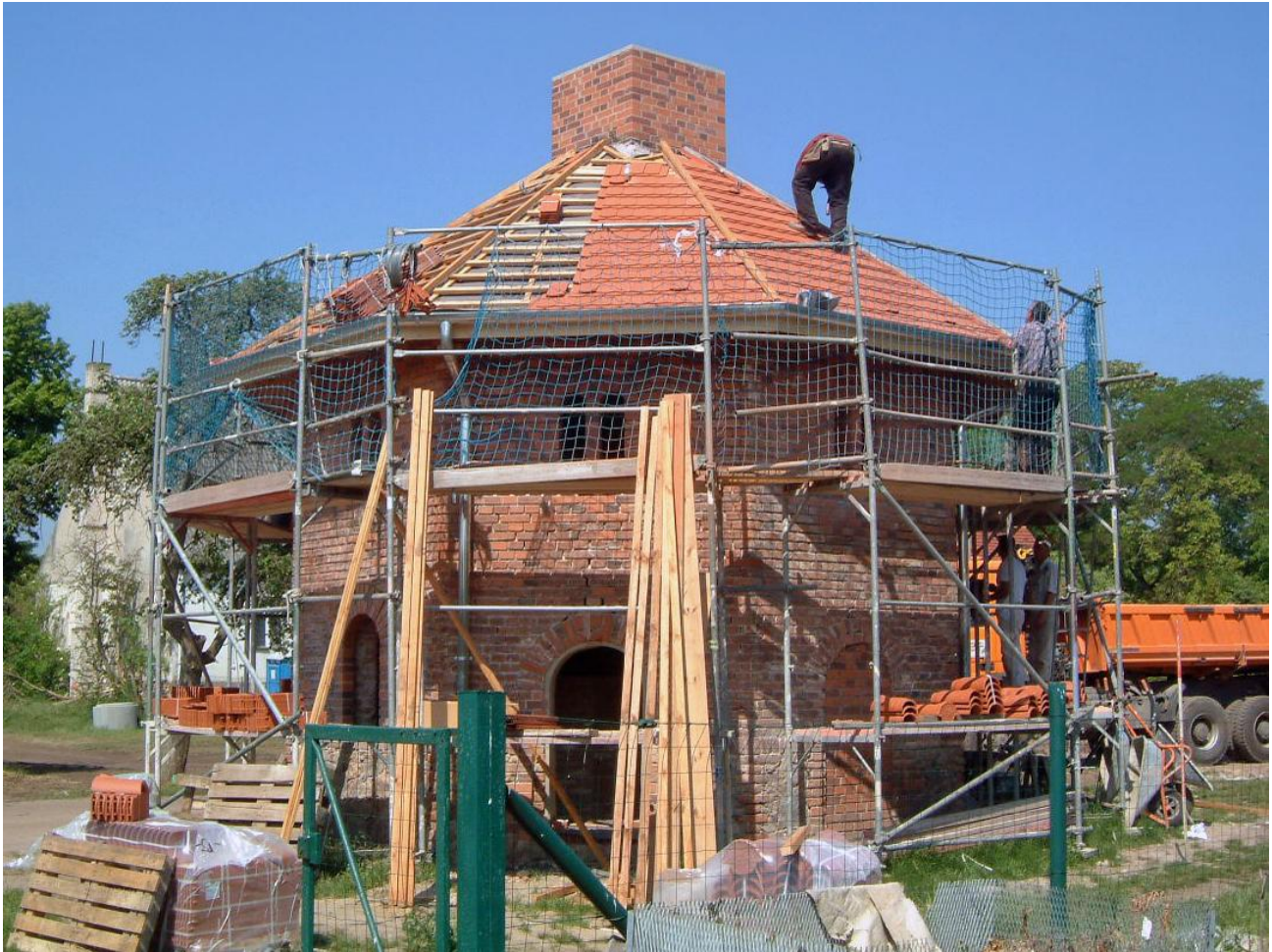
Neuer Dachstuhl, neuer Schornsteinkopf und Arbeiten an der neuen Dacheindeckung.
