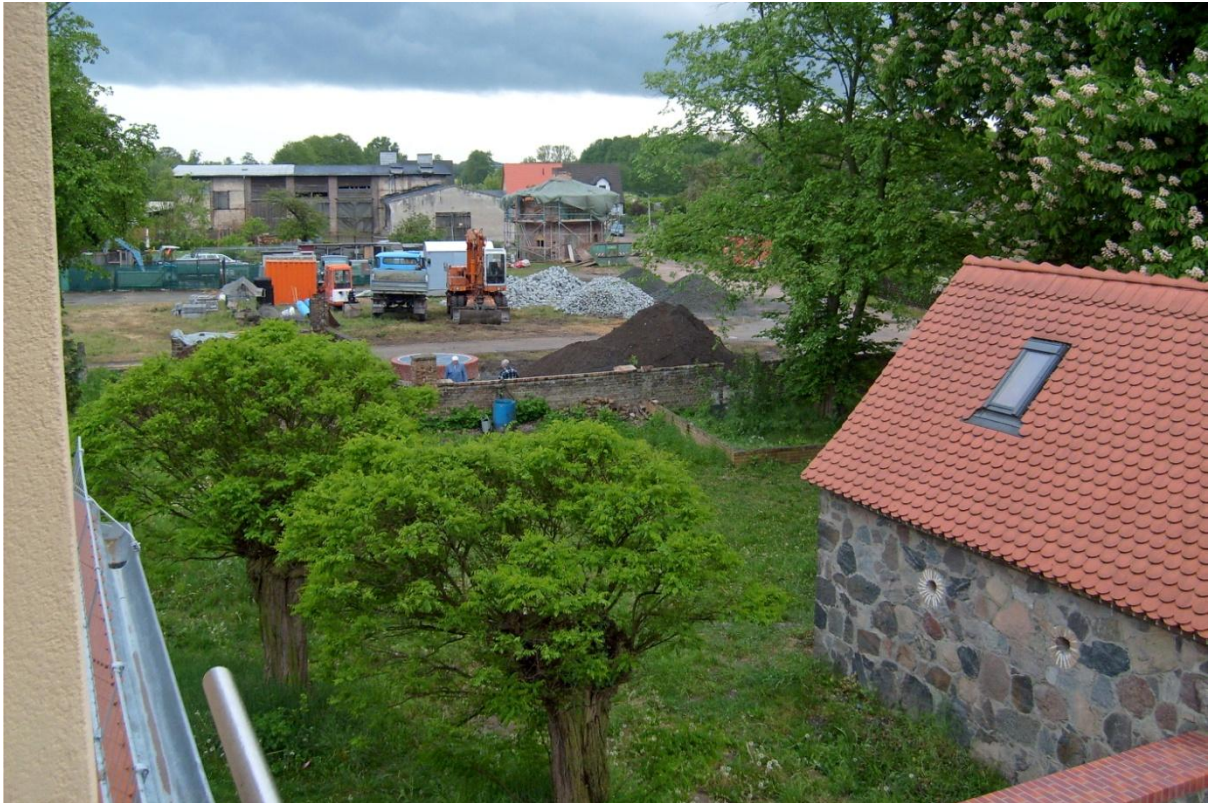
Frühjahr 2007 Blick aus dem neuen Feuerwehrdepot in Richtung Backhaus-Baustelle.
