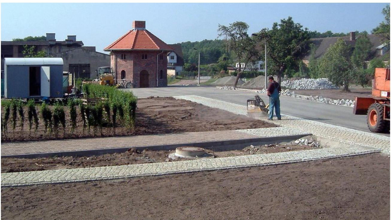
Nach dem Abschluss aller Erschließungsmaßnahmen und der Hochbaumaßnahmen auf dem Platz der Einheit erfolgte dessen Befestigung mittels Asphaltdecken und Pflasterungen mit Granitsteinen. Bilder Dipl. Ing. Rolf Kammel
