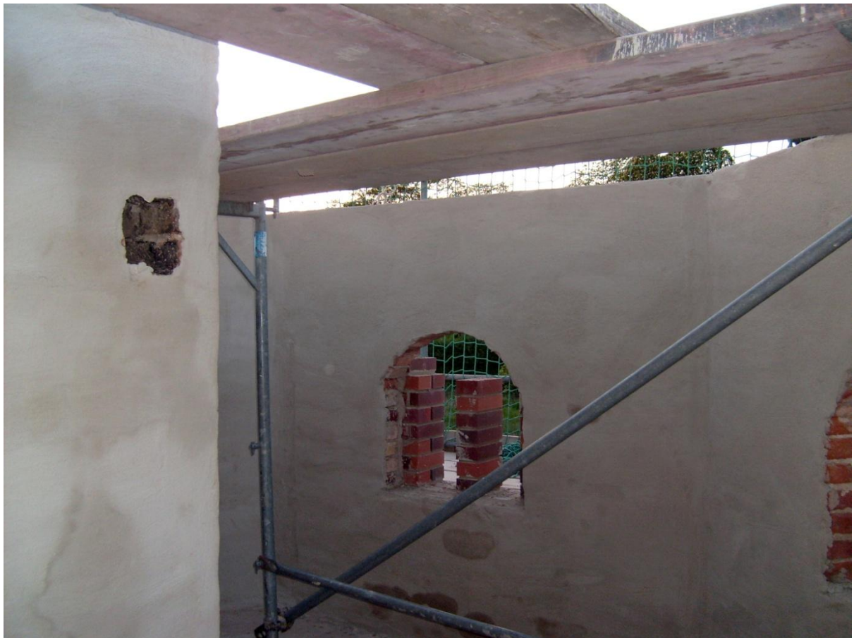
In der oberen Etage wurden die Räucherkammern bis auf eine entfernt um mehr Platz für die vorherige Teigzubereitung zu haben. Bilder Petra Gentes
