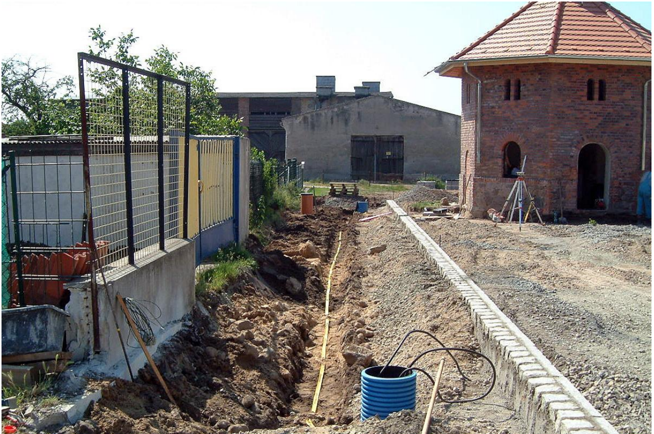
Zu den Neuerungen zählte der Anschluss des Backhauses an das öffentliche Trink- und Abwasser- netz. Die Stromversorgung wurde zeitgemäß per Erdkabel ausgeführt.
